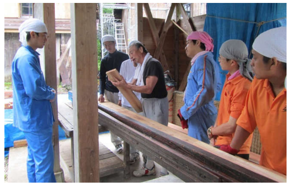
棟梁らによる直接指導②
